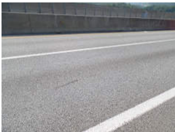
방호벽 전경 (여주)
